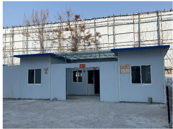
医疗废物暂存间
